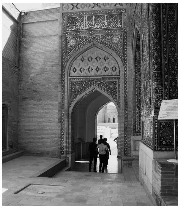
写真8 サマルカンドのシャーヒ・ズィンダ廟参道の排水孔付き敷石 (手前左寄りにみえる窪み部分)
