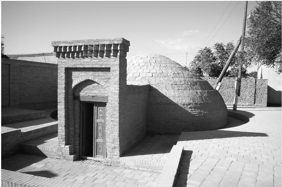
写真1 トルト・シャフバース・バーバー建築複合体構内における地底池の外観
