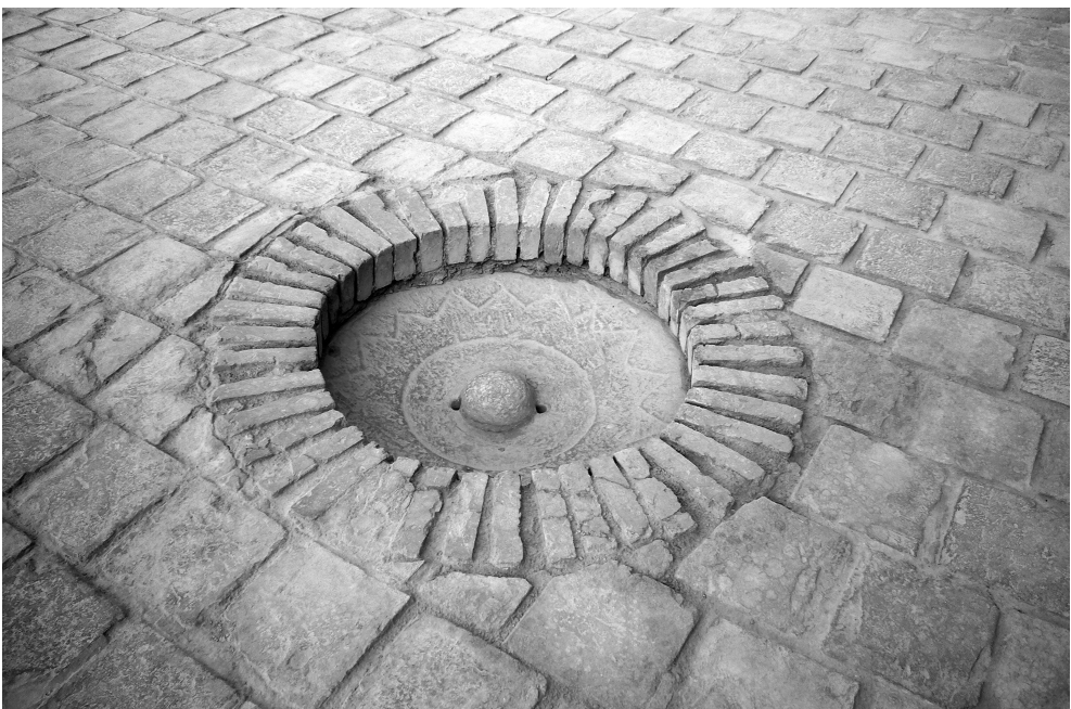
写真6 タシュハウリ宮殿中庭の排水孔付き敷石（トッシ）
